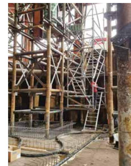
De staaltorens rusten op de nieuw aangebrachte paalfundering.
