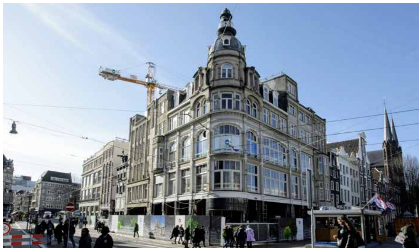
Negen monumentale panden aan het Koningsplein, in het centrum van Amsterdam, worden gerenoveerd en verbouwd tot luxe woon- en winkelcomplex.
