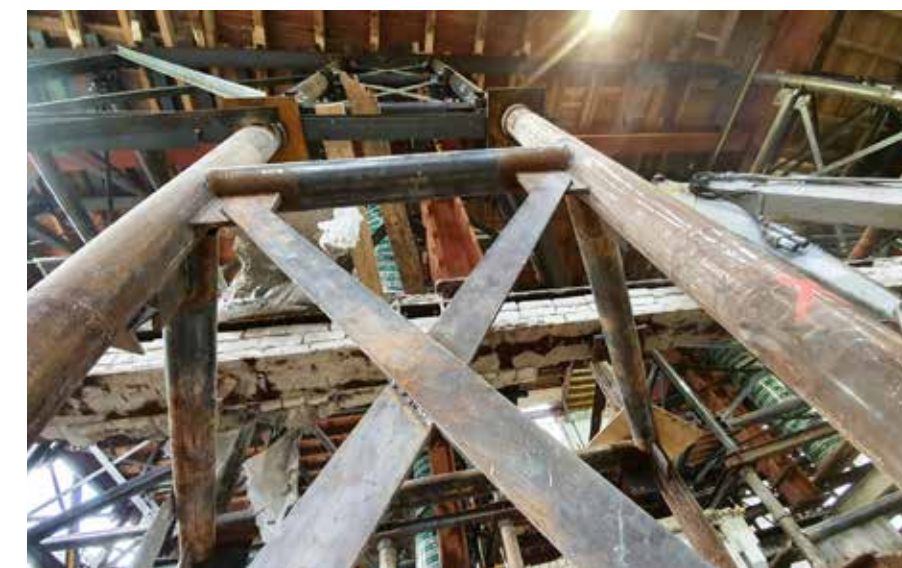
Eén van de staaltorens waarop de 'trambanen' steunen.
