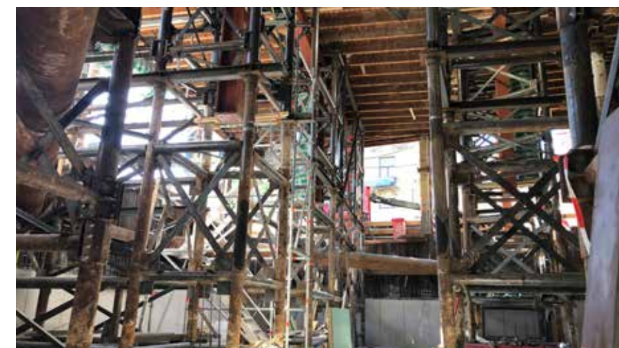
Het hulpstaal voor de ondersteuningsconstructie, in totaal meer dan 170.000 kilo, wordt allemaal weer verwijderd.
